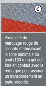
Possibilité de marquage rouge de sécurité matérialisant la zone minimale du pont (150 mm) qui doit être en contact avec la remorque pour assurer un transbordement en toute sécurité.
