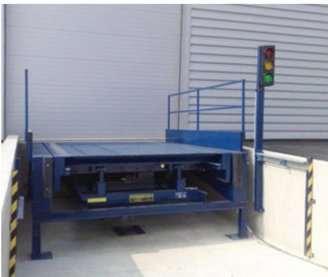
Particulièrement utile en cas de présence d'une table élévatrice, ce kit d'approche permet de signaler au chauffeur la progression de l'approche du quai ou de la table et d'éviter ainsi une mise à quai trop brutale, qui endommagerait la table ou le nez de quai et bien sûr le camion.
